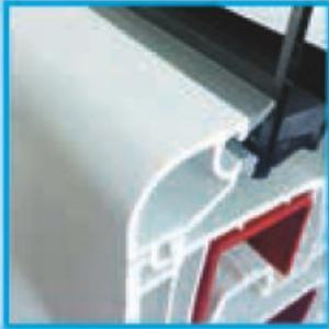
**Glashalteleiste** – ein Türelement, das zur Befestigung des Mehrscheiben-Isolierglases und / oder Sandwichplatten oder MDF erforderlich ist.
