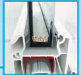
**Mehrscheiben-Isolierglas** - Mehrscheiben-Isolierglas in der Türkonstruktion macht die Tür durchsichtig. Nach dem Wunsch des Kunden kann das Mehrscheiben-Isolierglas als ein dekorativer Teil verwendet werden (Mehrscheiben-Isolierglas mit Ornamentglas, Mehrscheiben-Isolierglas mit Sprossen, Inkrustation, Glasmalerei oder Sandstrahlen-Ornamenten).
